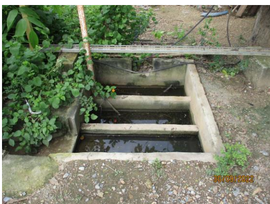
รูปที่ 2-12 บ่อดักคราบน้ำมันของโครงการ
