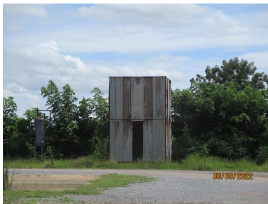
รูปที่ 2-7 ติดตั้งแผ่นกันรอบปล่องเผาก๊าซ
