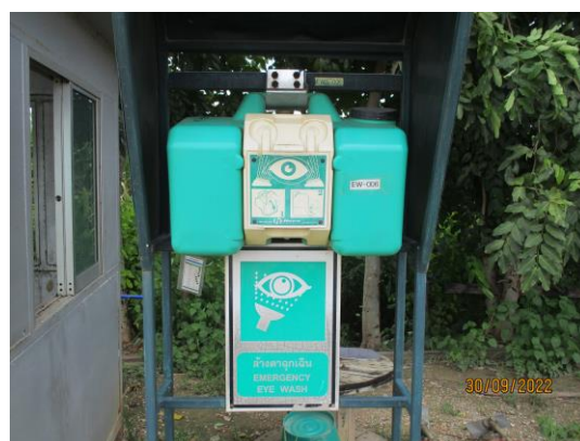
รูปที่ 2-34 อุปกรณ์ล้างตาฉุกเฉิน (Emergency Eye Wash)
