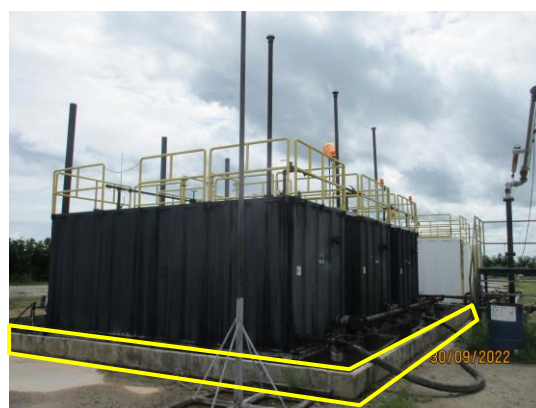
รูปที่ 2-16 คันคอนกรีตล้อมรอบถังเก็บน้ำมันดิบและน้ำจากกระบวนการผลิต
