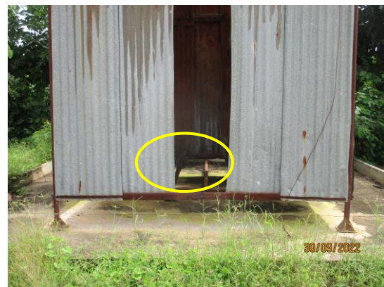
รูปที่ 2-8 ปล่องเผาก๊าซที่มีความสูงไม่เกิน 2 เมตร จากระดับฐานหลุมผลิต
