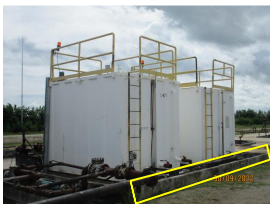
รูปที่ 2-16 คันคอนกรีตล้อมรอบถังเก็บน้ำมันดิบและน้ำจากกระบวนการผลิต
